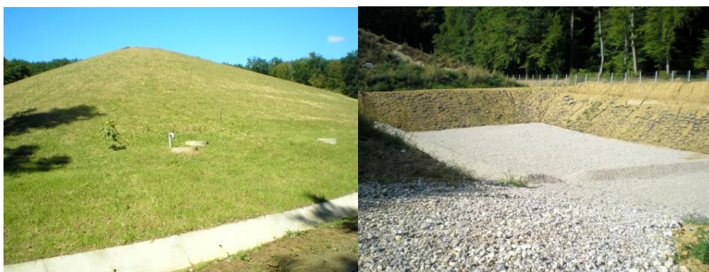
Slika 7. Odlagalište otpada “Ivančino brdo” nakon izvršene sanacije
