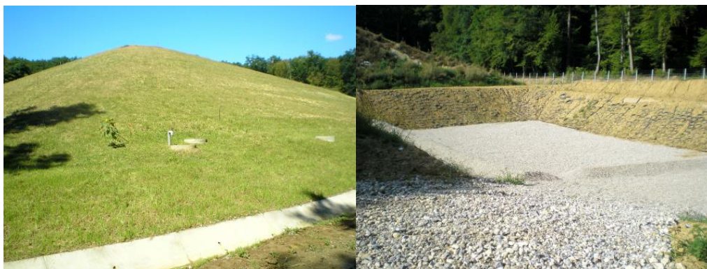
Slika 9. Odlagalište otpada “Ivančino brdo” nakon izvršene sanacije
