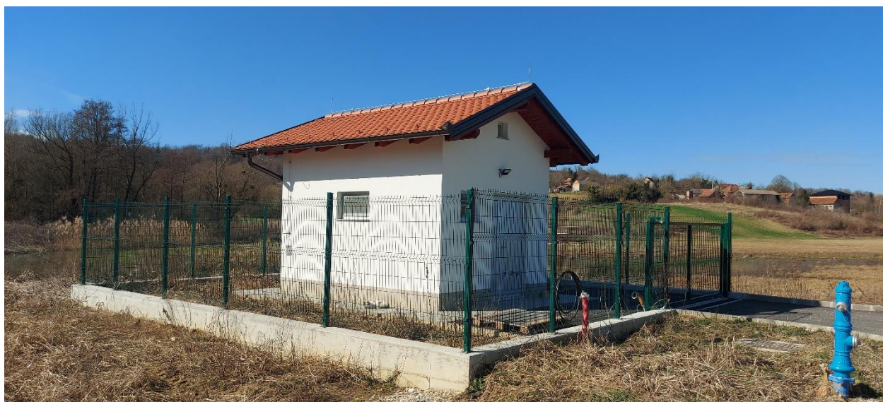
Slika 17.: Stanje na terenu - novoizgrađena precrpna stanica Nemčevac Izvor: Zavod za prostorno uređenje Koprivničko-križevačke županije, 21.02.2024.
