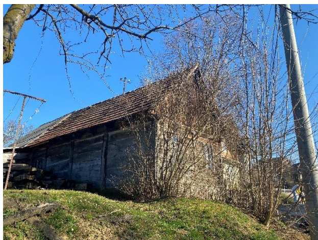
Slika 31.: Primjer stare gradnje u Kostanjevcu Riječkom
