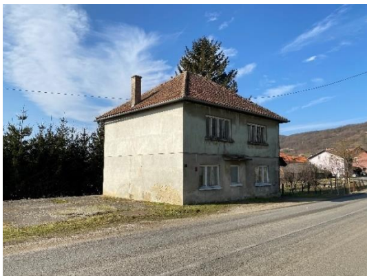
Slika 71.: Stanje na terenu - stara zgrada Doma zdravlja Koprivničko-križevačke županije
