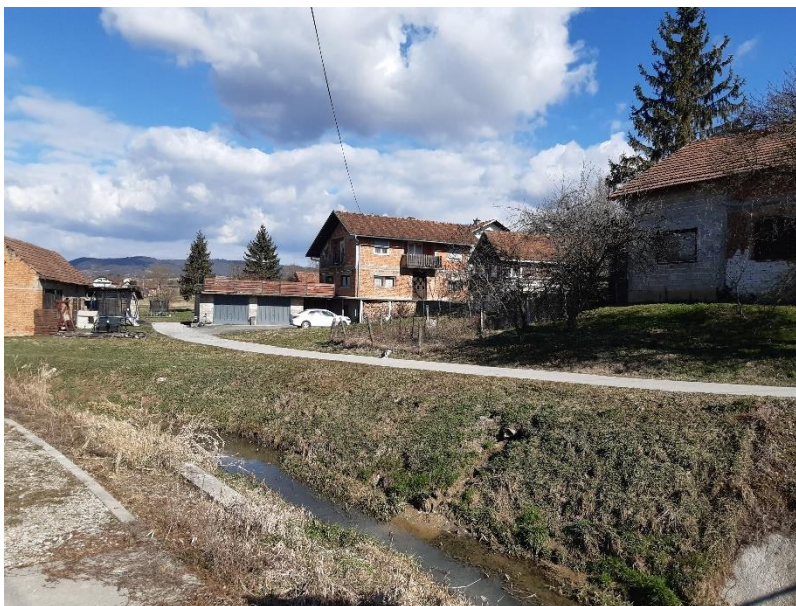
Slika 126.: Primjer ispuštanja otpadnih voda direktno u potok Brodi u naselju Pofuki
