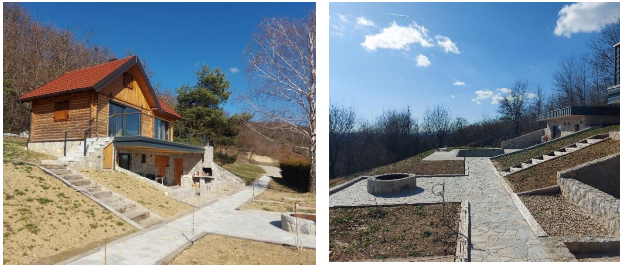
Slika 38.: Primjer kuće za odmor s bazenom u izgradnji u naselju Gornja Rijeka
