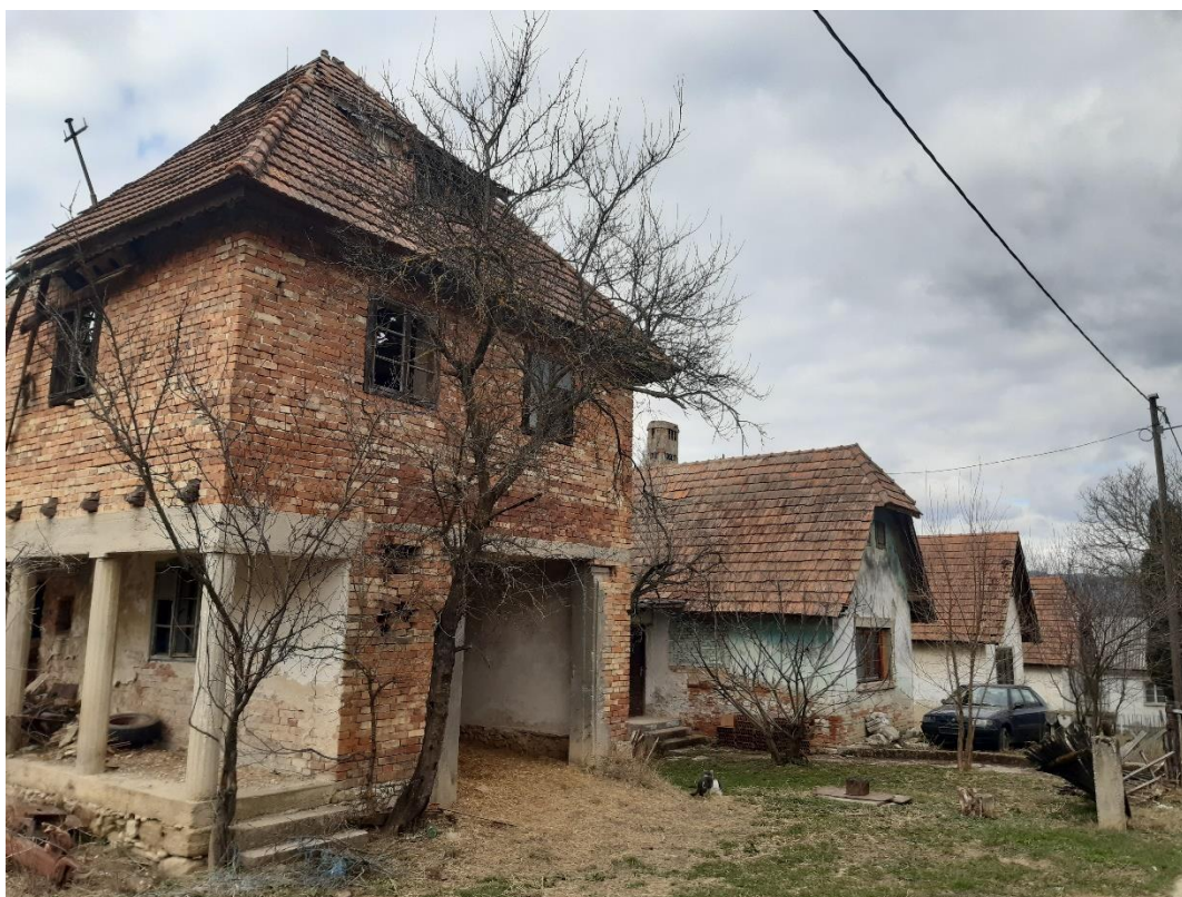
Slika 114.: Graditeljska baština u selu Kolarec (jasno prepoznatljiva građevinska linija stambenih objekata nakon obnove)
