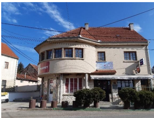
Slika 72.: Stanje na terenu - Poslovna zgrada na Trgu Sidonije Rubido Erdödy 2
